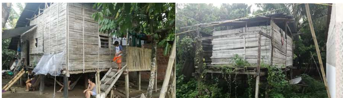
Figura 2. Estructura de vivienda en caña guadua de los sectores Arrastradero y EL Limón.
