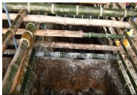
Figura 1. Construcción de los corrales con caña guadua y cadí.
