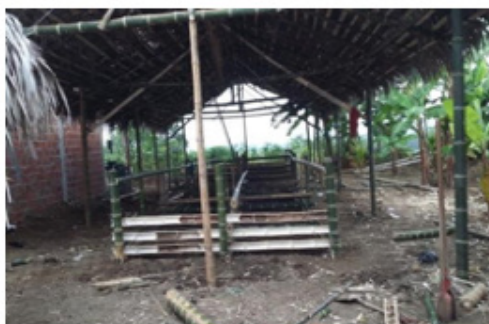
Figura 1. Construcción de los corrales con caña guadua y cadí.
