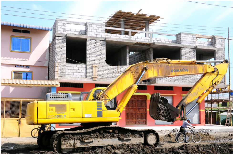
Figura 9. Retroexcavadora con cilindros de doble efecto.
